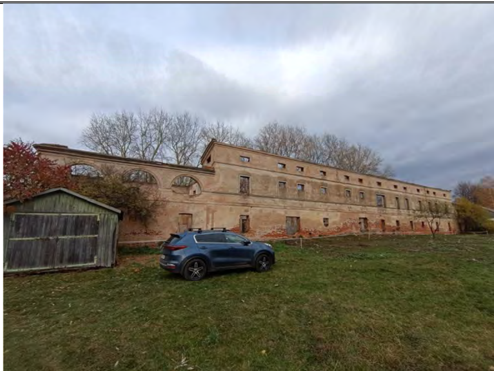
Фото 4 Общий вид обследуемого здания
