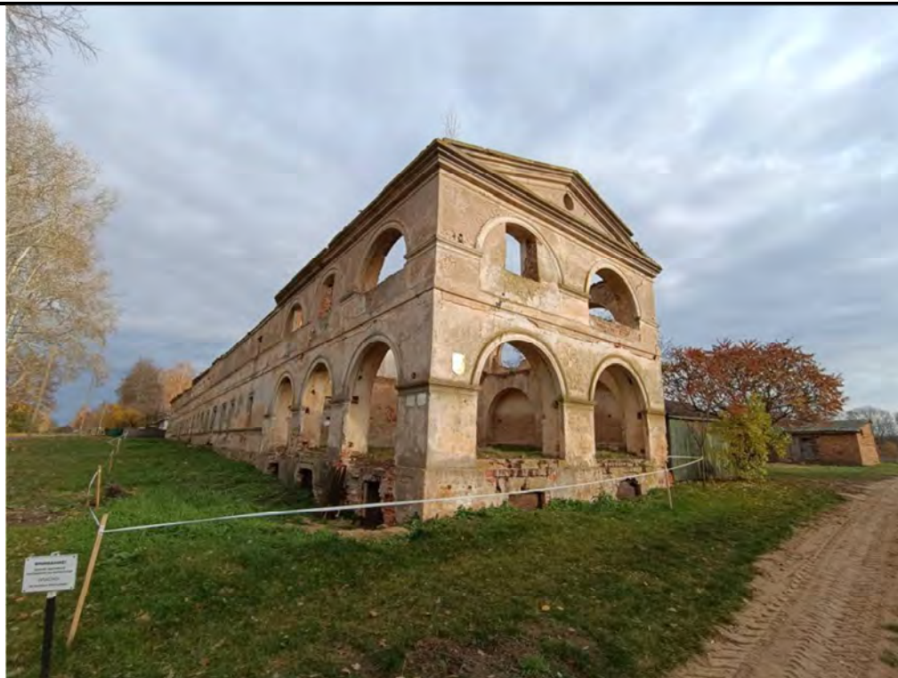
Фото 5 Общий вид торцевого фасада здания
