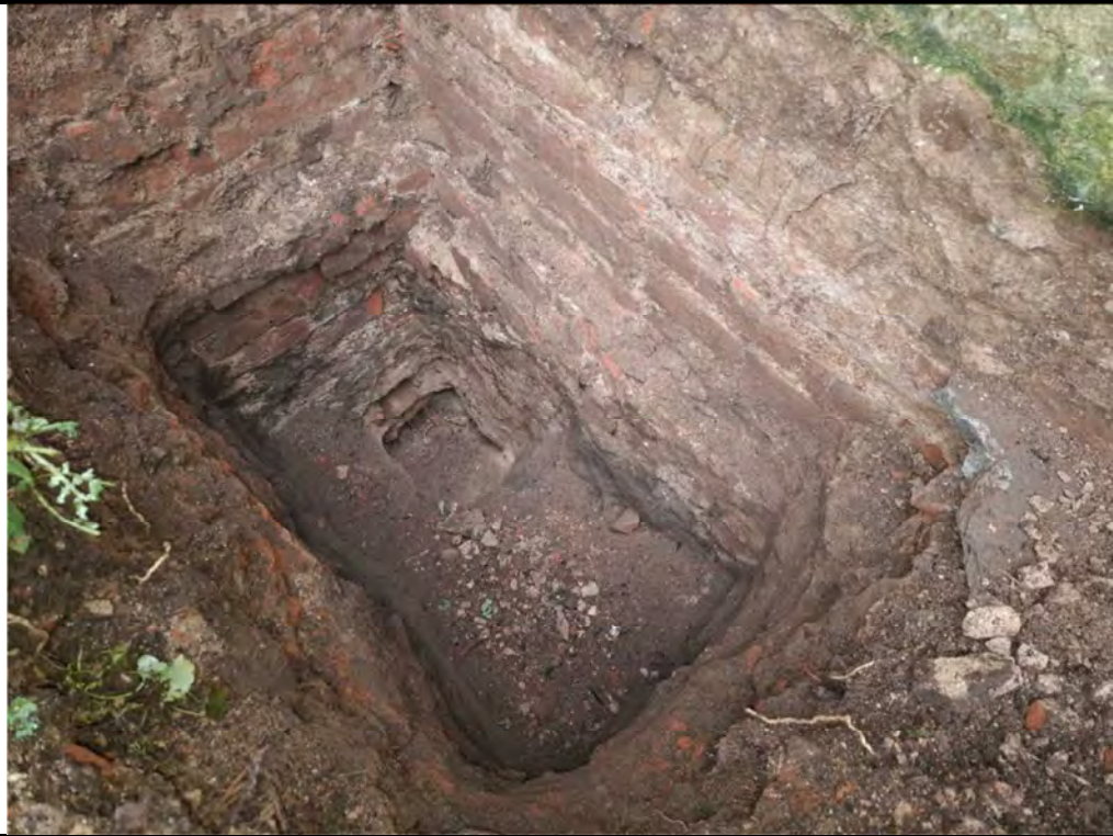
Фото 105 Фрагмент фундаментов наружных стен пристройки на участке откопки шурфа (шурф №3)
