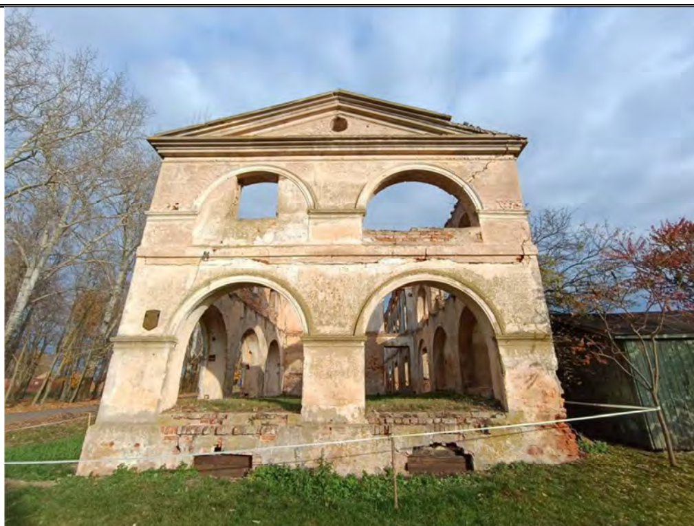
Фото 6 Общий вид торцевого фасада здания
