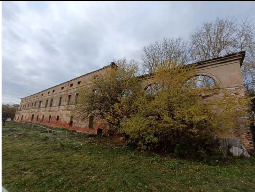
Фото 3 Общий вид обследуемого здания
