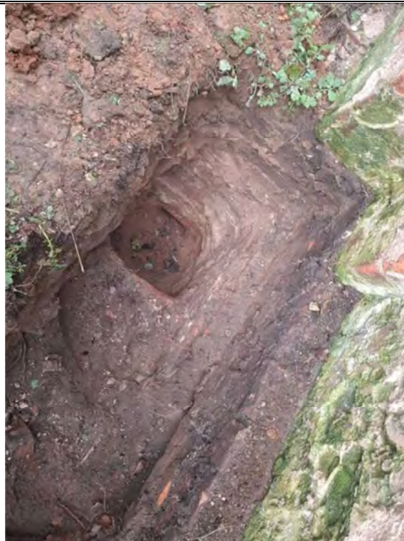
Фото 106 Фрагмент фундаментов наружных стен пристройки на участке откопки шурфа (шурф №3)
