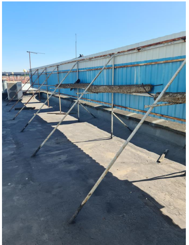
Фото 64. Общий вид ограждающе-декоративных конструкций кровли в осях А/3-4
