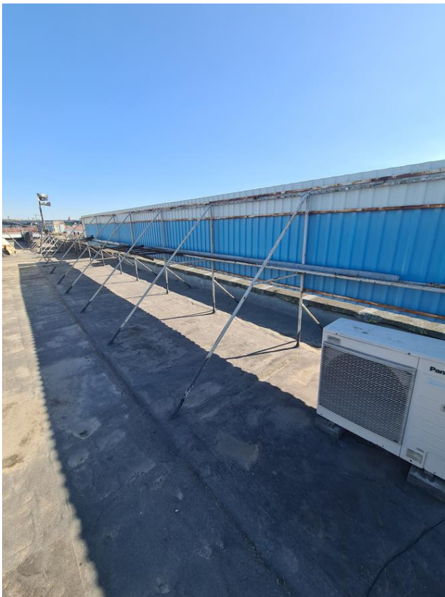
Фото 63. Общий вид ограждающе-декоративных конструкций в осях А/3-4
