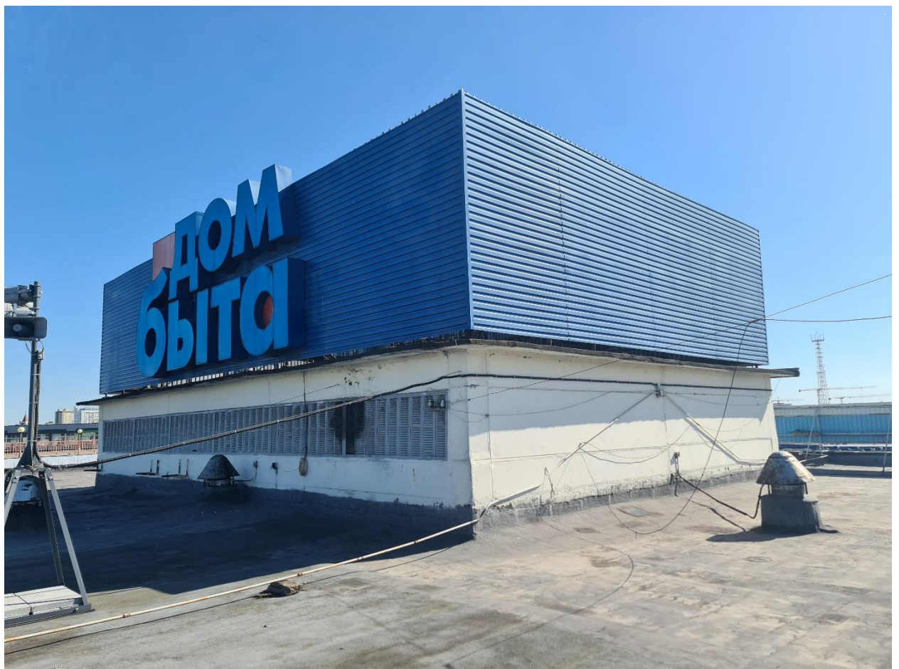
Фото 75. Общий вид технического этажа (надстройки) в осях Б-В/2-3
