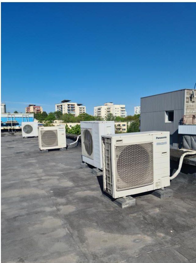
Фото 71. Общий вид оборудования на поверхности кровли в осях Б-Г/4
