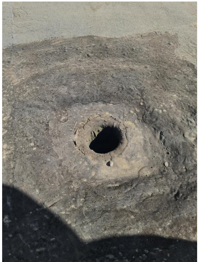
Фото 52. Отсутствует листоуловитель. Расположение и количество водоотводящих воронок не соответствующим действующим ТНПА
