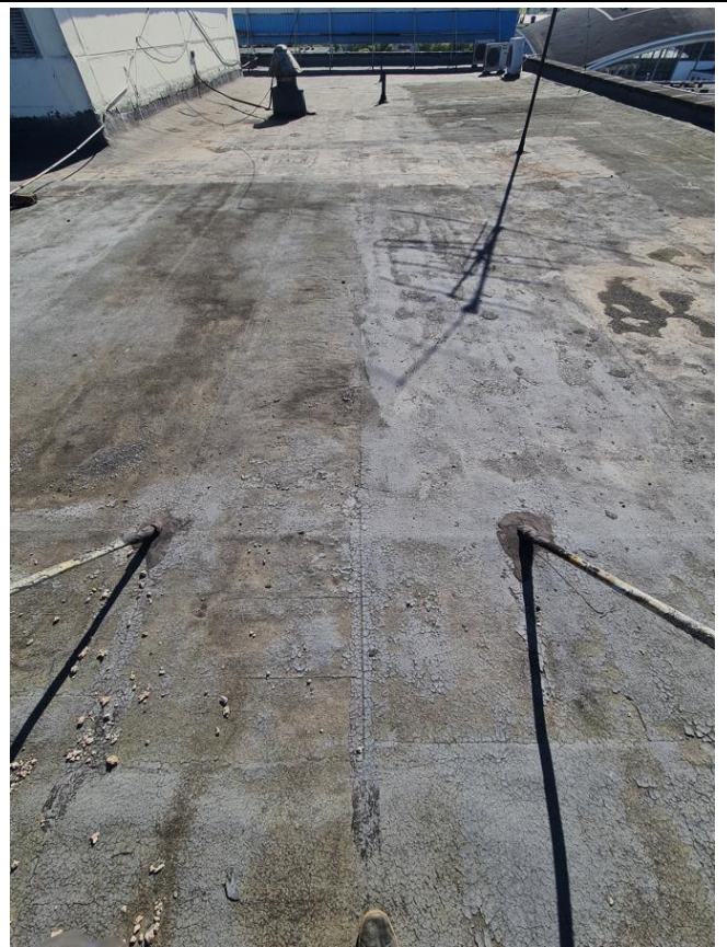
Фото 6. Следы застаивания атмосферных осадков, бугристости рулонного ковра в осях Г-А/2-1
