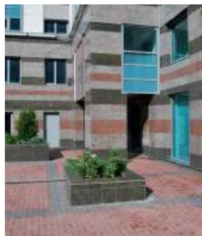
Санкт-Петербург. Элитный ЖК «Идеальный мир»
