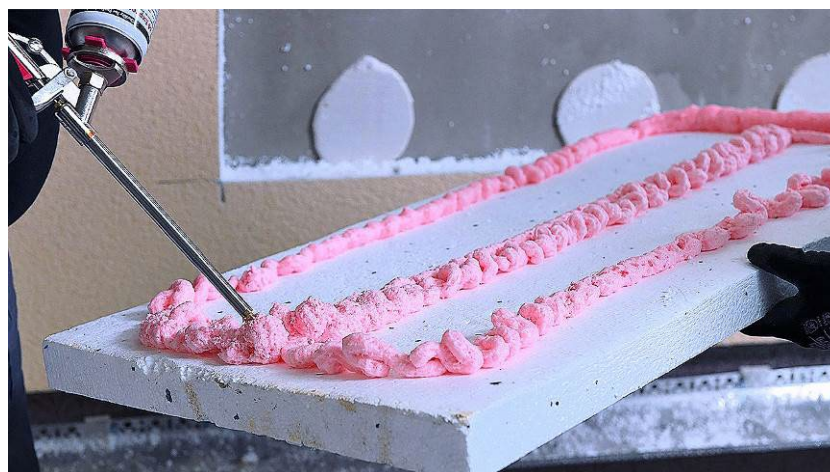
Рисунок 11 – Нанесение полиуретанового клея Ceresit
