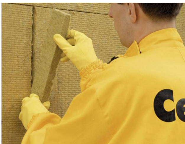
Рисунок 16 – Заделка щелей между теплоизоляционными плитами
