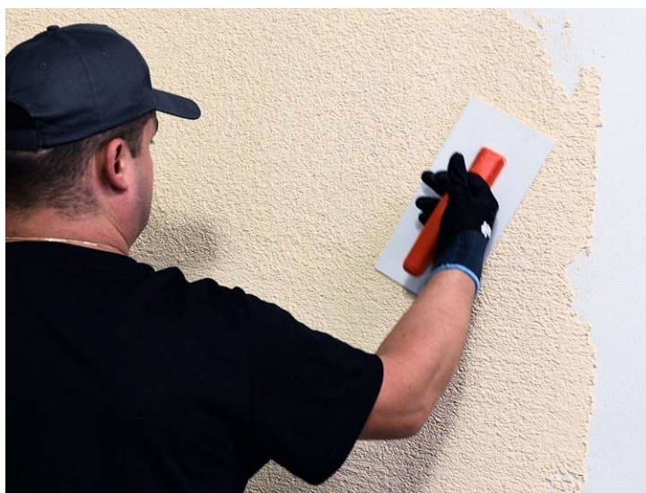
Рисунок 34 – Придание поверхности фактуры при помощи пластмассовой терки
