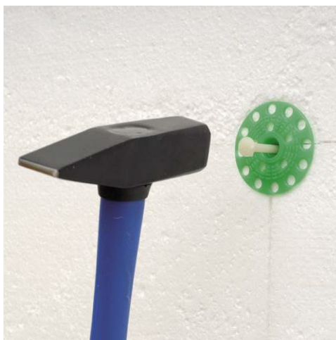
Рисунок 24 – Установка сердечника при помощи молотка
