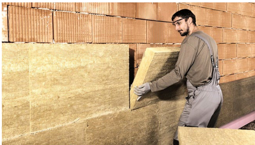
Рисунок 13 – Приклеивание теплоизоляционных плит
