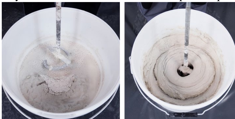
Рисунок 36 – Приготовление декоративного состава
