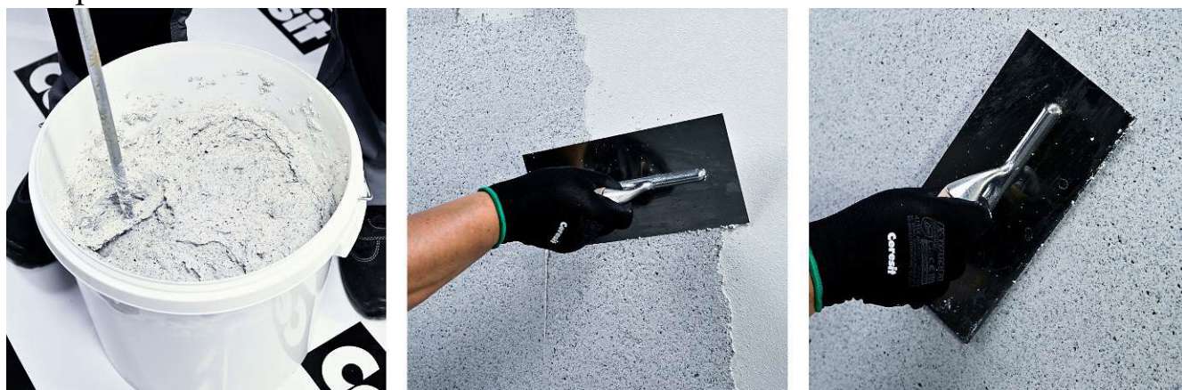
Рисунок 35 – Нанесение штукатурки с фактурой натурального камня
