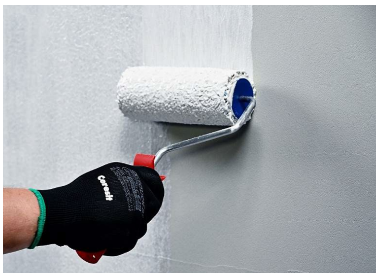
Рисунок 32 – Грунтование армированного слоя
