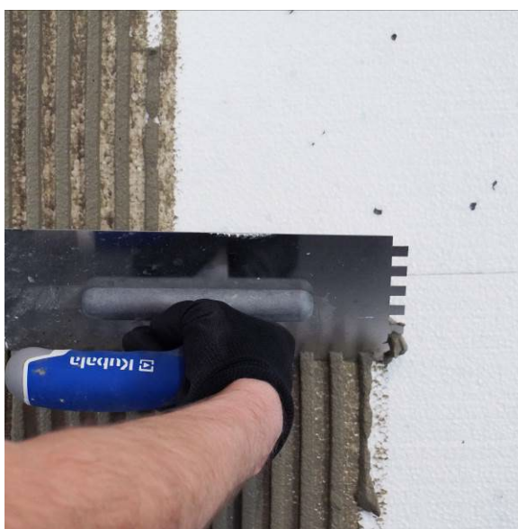
Рисунок 28 – Нанесение клеевого состава на теплоизоляционный слой
