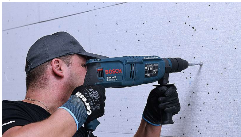
Рисунок 22 – Сверление отверстий электроперфоратором
