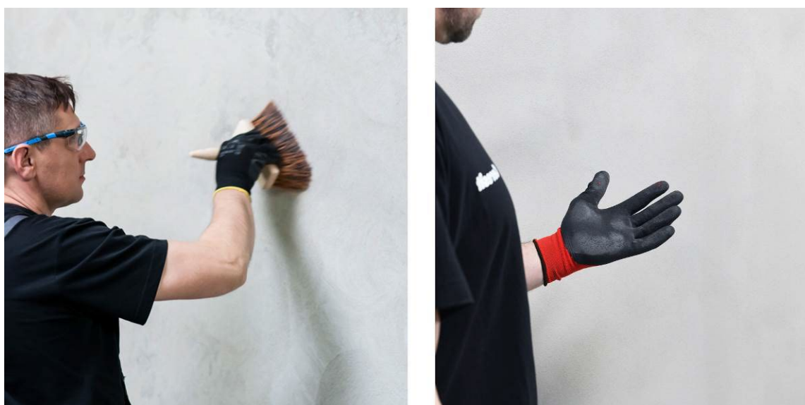
Рисунок 3 – Очистка поверхности щеткой
