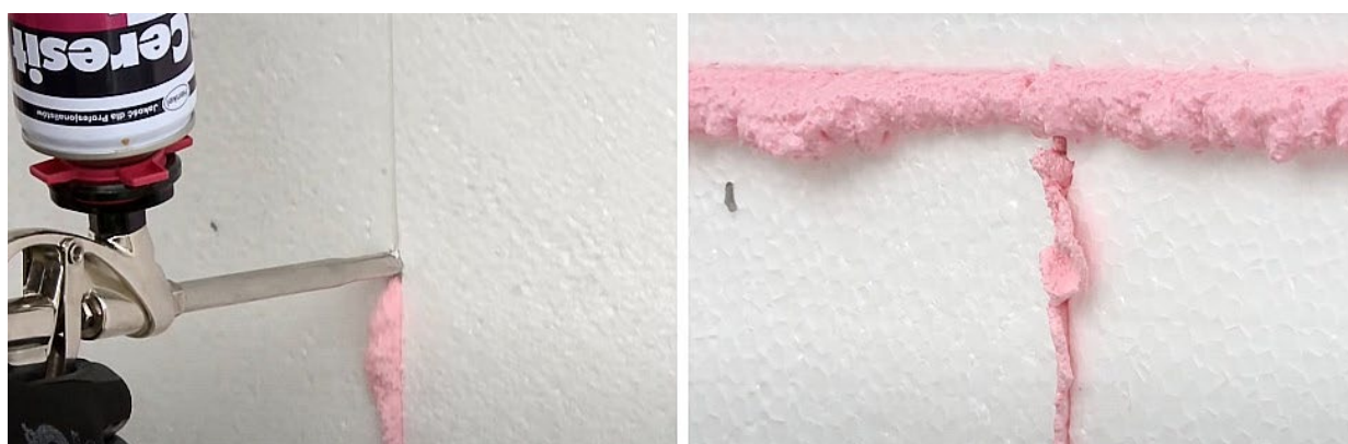
Рисунок 17 – Заделка швов монтажной пеной
