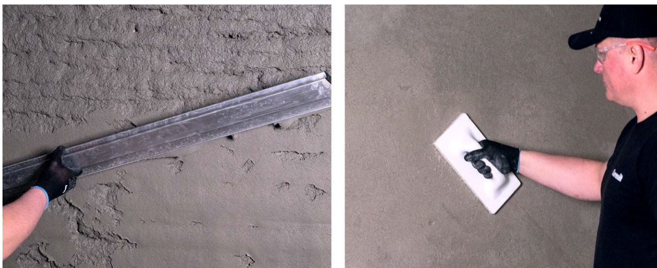
Рисунок 5 – Нанесение выравнивающей смеси на поверхность
