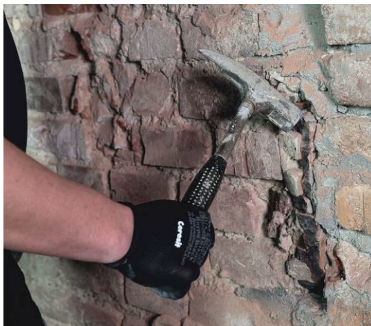
Рисунок 4 – Удаление непрочных участков основания при помощи молотка и скarpеля
