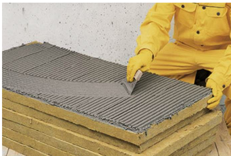
Рисунок 10 – Нанесение клеевого состава методом сплошного приклеивания
