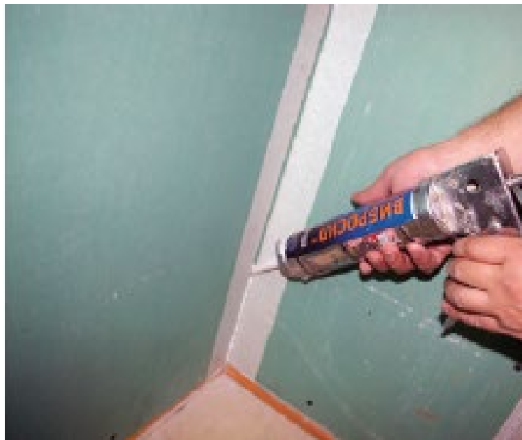
Рисунок 24. Заполнение швов герметиком Вибросил.
